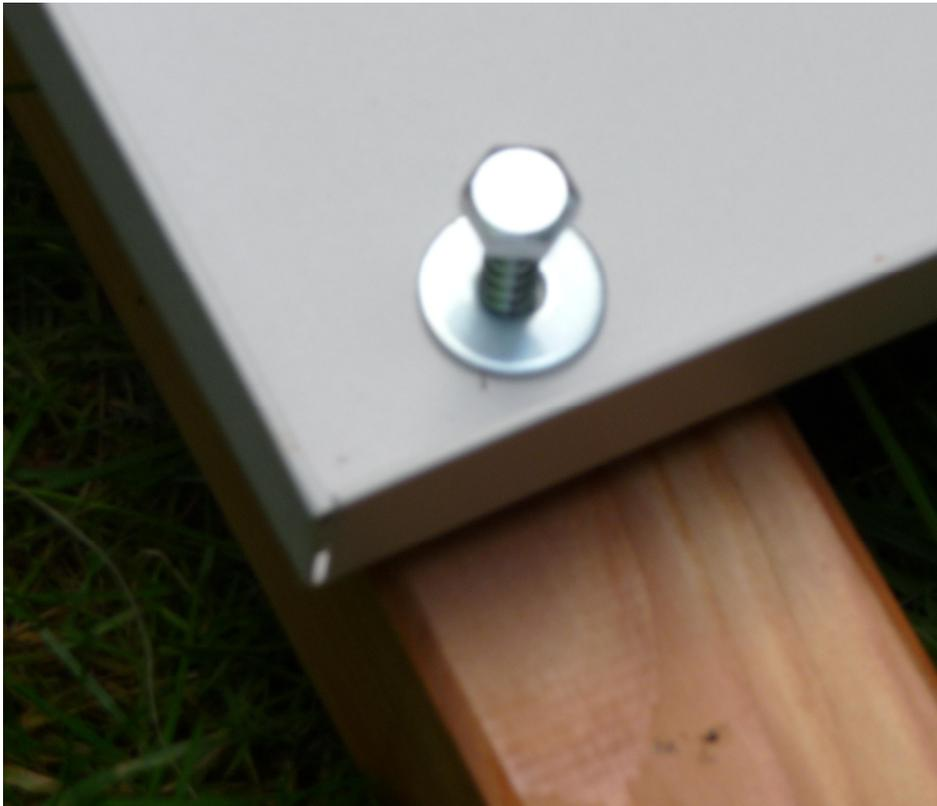
Nun werden von der aufgekanteten Seite des Metallteils (Innenseite) her die ersten Holzschrauben zunächst handfest angezogen. Bitte geben Sie bei der Platzierung der Unterlegscheiben darauf Acht das die flache Seite der Scheibe auf der Metallfläche aufliegt.
