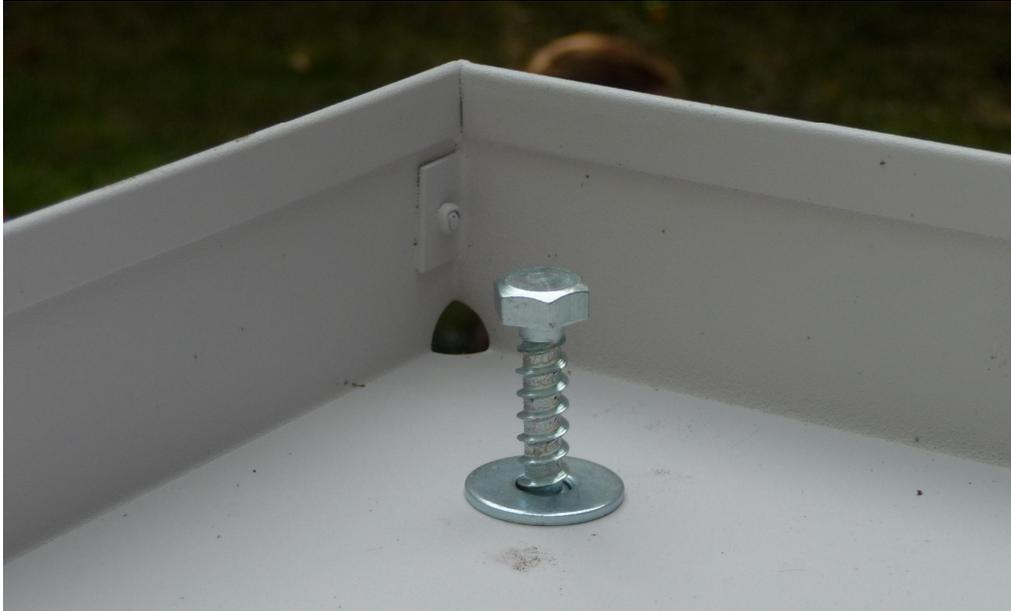
Die Dachwanne wird, wie herum auch immer, mit den gleichen wie zu vor benutzten Schrauben auf den Holzpfosten montiert. Zunächst bitte nur halb eindrehen, da das Dach zur Montage des vorderen Mittelholmes noch ein wenig angehoben werden muß.
