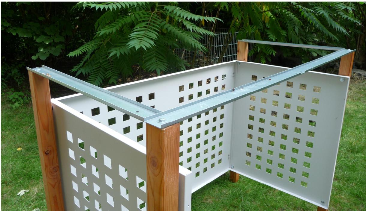
Danach wird der umlaufende feuerverzinkte Rahmen mit den gleichen Holzschrauben wie in Montageschritt 1 auf die Holzpfosten montiert. Die Kanten nach unten (d.h. Richtung Erdboden) und die Aussparung in der vorderen Querstrebe in Richtung der später folgenden Türen.
