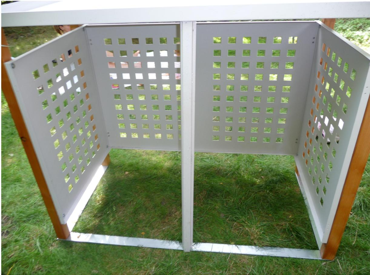
Nun ist der Mittelholm montiert und man kann zur Montage der Türen übergehen.
