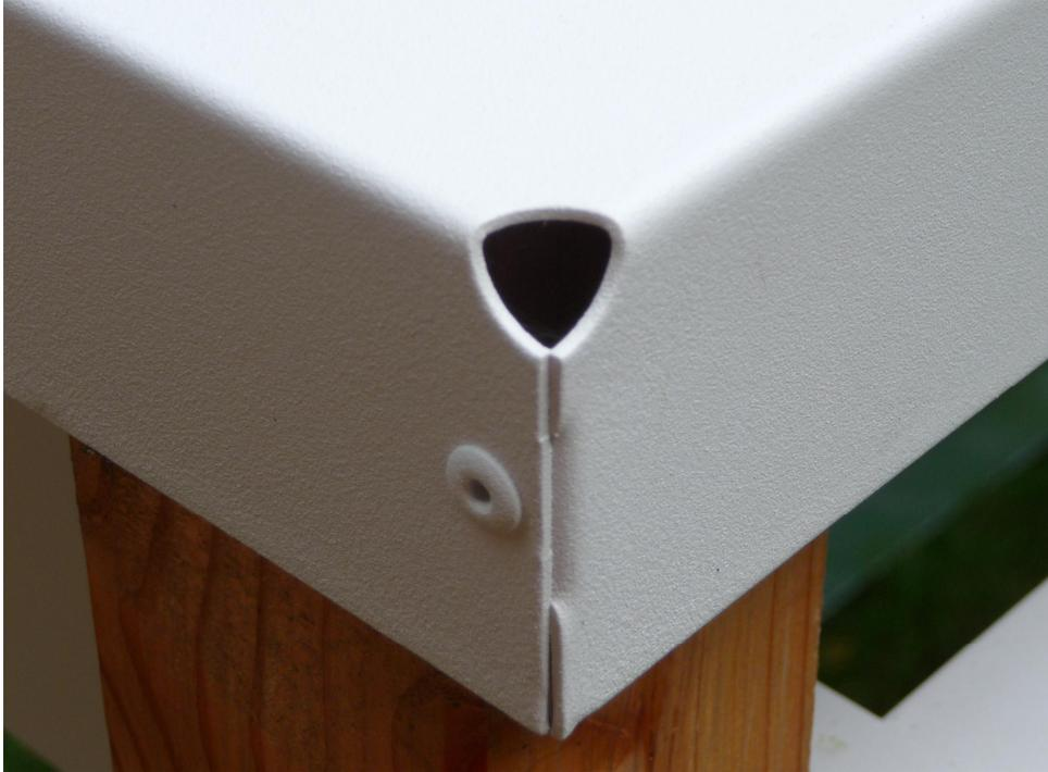
Ein Detailbild der frei geschnittenen Ecken der Dachwanne, die bei der Montage als Pflanzwanne den gleichmäßigen Wasserablauf an allen vier Ecken sicherstellen.
